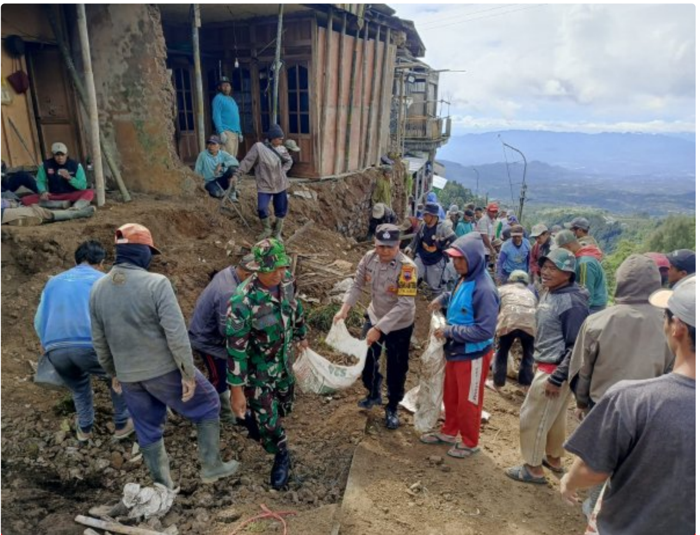
(Foto Dokumen) : Gotong royong pembersihan material longsor
